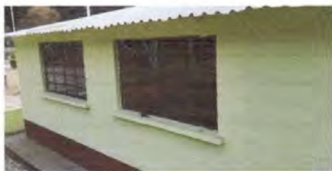
Foto13: Fabricación e instalación de balcones de hierro en ventanas. Módulo Uno
