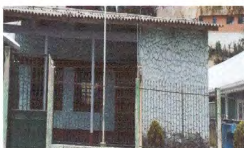
Foto 11: Mantenimiento a barandas de metal módulo uno
