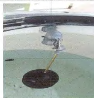
Foto 8: Reparación de accesorios de depósito de agua. Módulo dos
