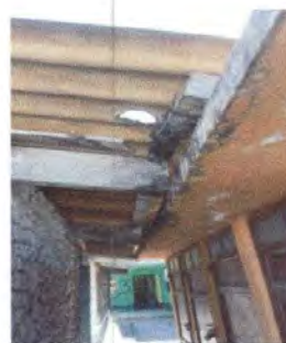
Foto 2: Sustrucción de soporte madera por metal Módulo 2
