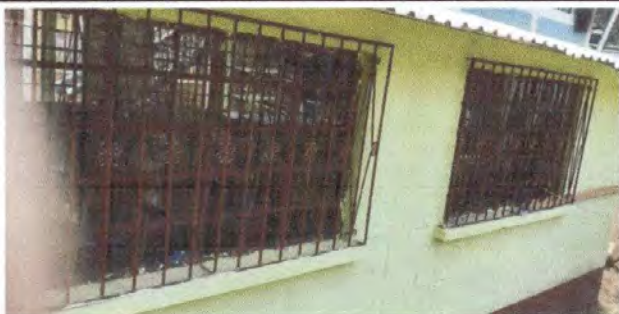
Foto 7: Mantenimiento a balcones de metal módulo uno y dos
