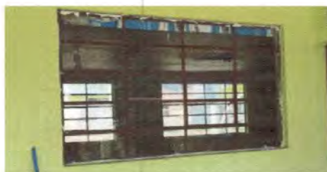
Foto 14: Fabricación e instalación de balcones de hierro de en ventanas Módulos.
